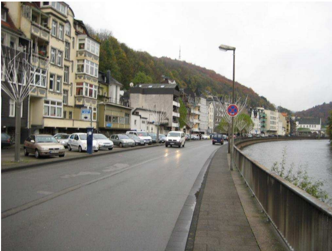
Straße vor Umbau
