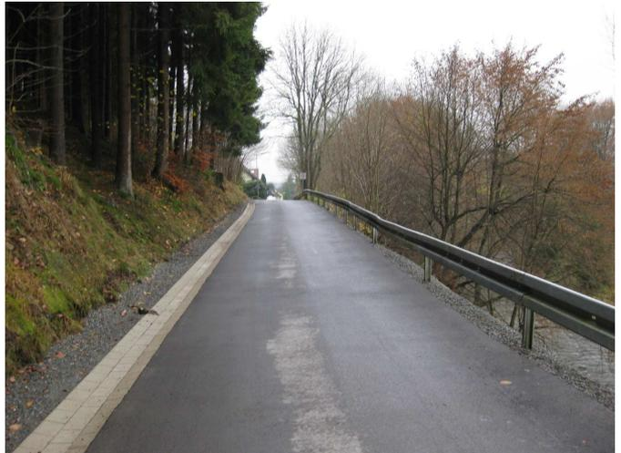
*neue Fahrbahn mit „gedrehter“ Entwässerung*
