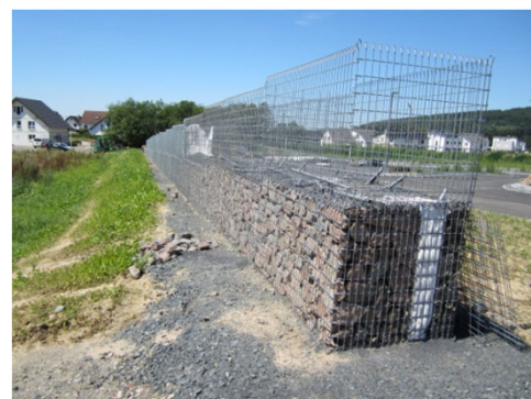
Lärmschutzwand während Bauphase
