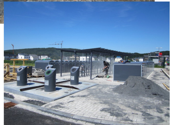
Fahrrad- und Glascontainerfläche während Bauphase
