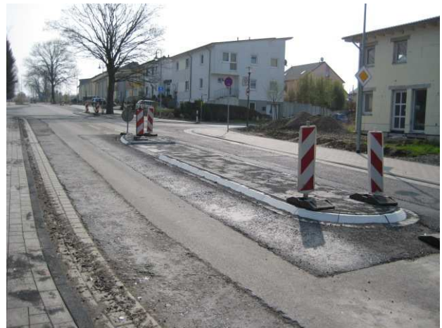
Querungshilfe im Bau
