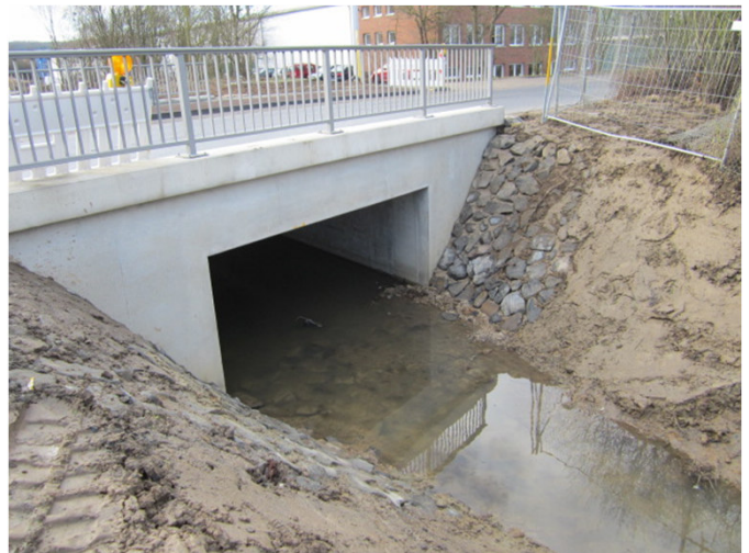
Neuer Durchlass „Reutherstraße“
