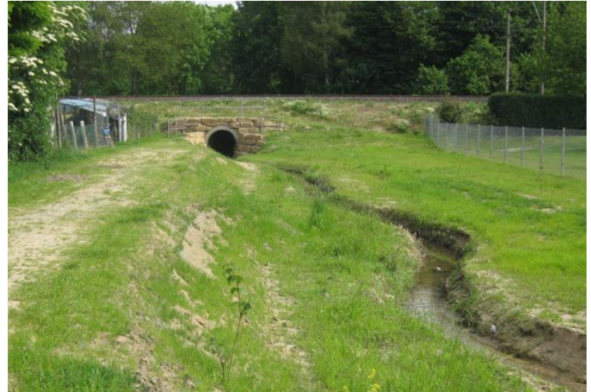
Neuer Bachlauf und Bahndurchlass
