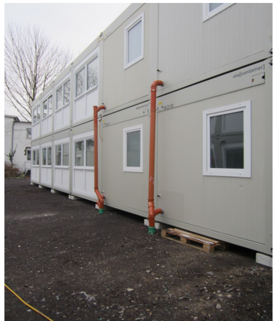
Container, zwei-stöckig, von hinten (Wohn- und Sanitär-Container)
