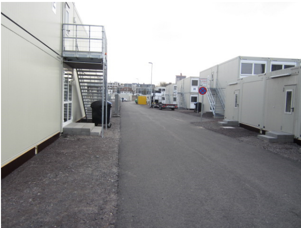
Zufahrtstraße mit beidseitigen Containern
