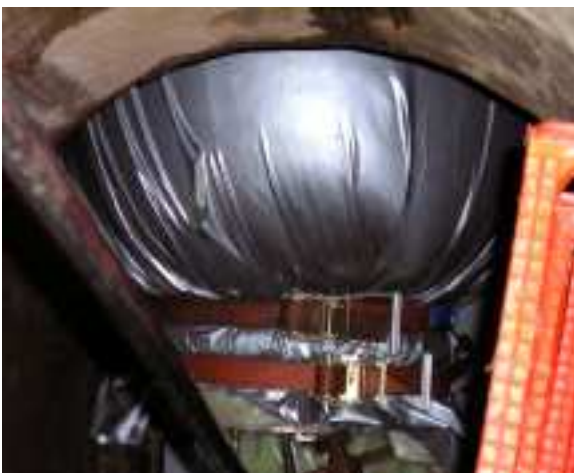
Packersystem im Startschacht
