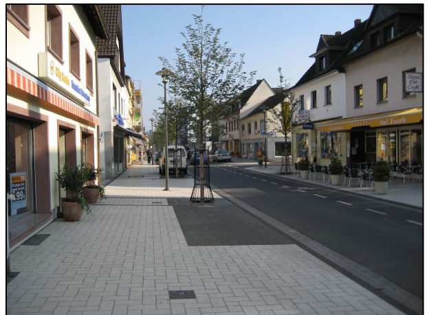
Nach dem Umbau
