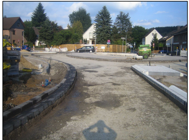
Bau der Kreisverkehrsanlage
