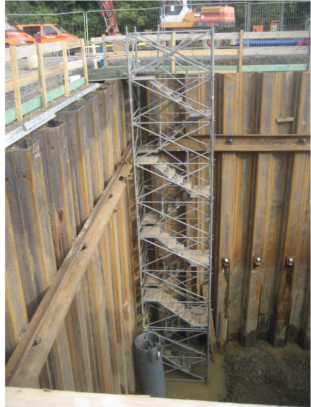
Baugrube für das Pumpwerk
