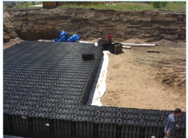
Bau der Versickerungsanlage I
