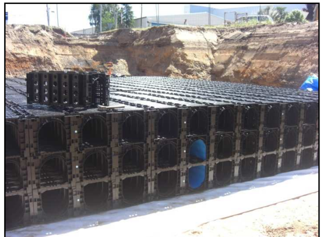
Bau der Versickerungsanlage II
