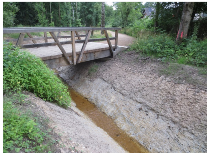
neue Holzbrücke für Spaziergänger
