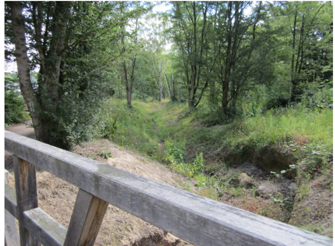
neuer Bachlauf 2 Jahre nach Fertigstellung
