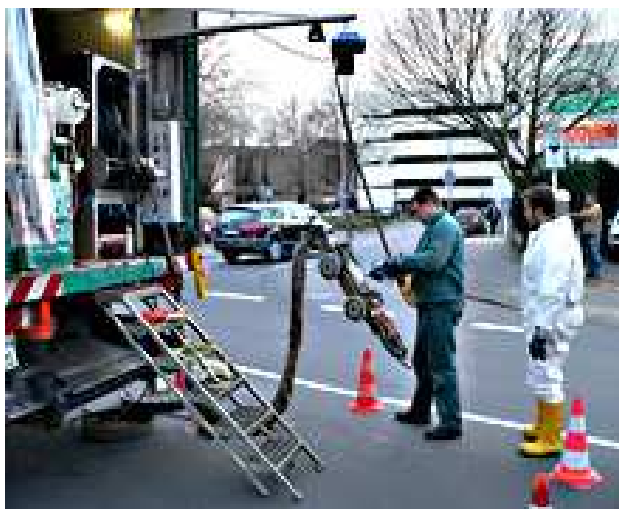
Einsatz des Fräsroboters
