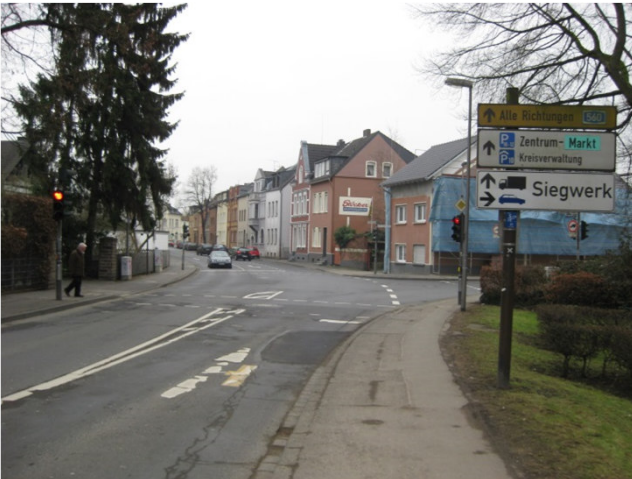
Der Knotenpunkt vor der Umbaumaßnahme
