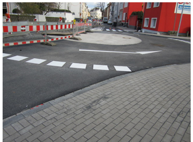
Bau des Kreisels unter laufendem Verkehr
