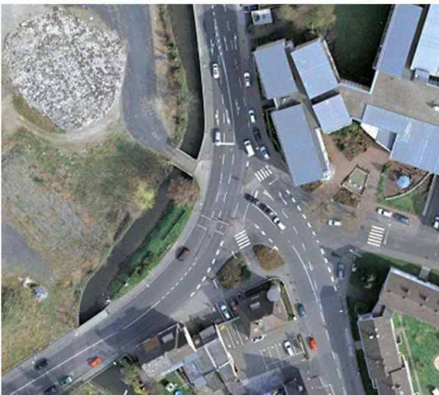
Ehemalige Kreuzung Friedrich-Ebert-Str./Bachstraße
