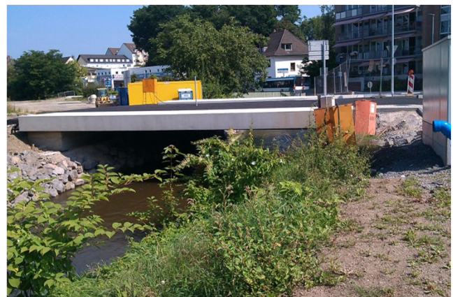
Neubau der Brücke über dem Mühlengraben
