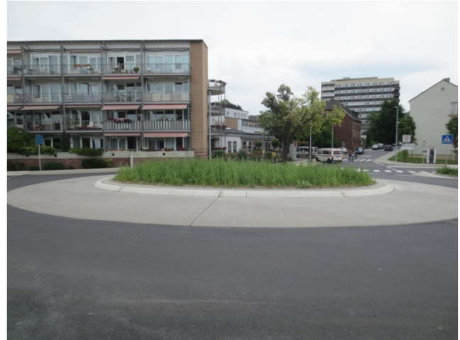
Minikreisverkehrsanlage nach Fertigstellung
