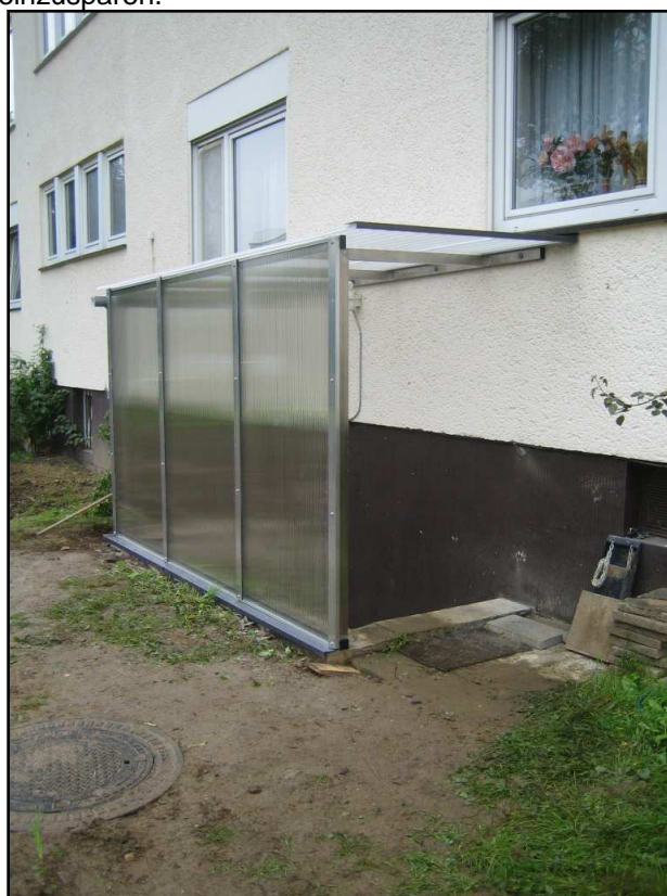
Überdachung von Kellertreppen
