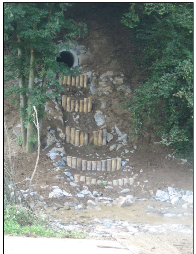
Kaskadenbauwerk zur Energieumwandlung
