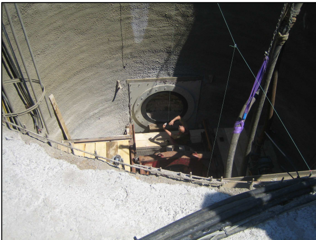
Startgrube vor Beginn der Bohrung
