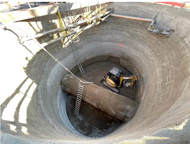
Baugrube/Ausfahrgrube Kapellenweg Bauphase: Freilegung Altkanal
