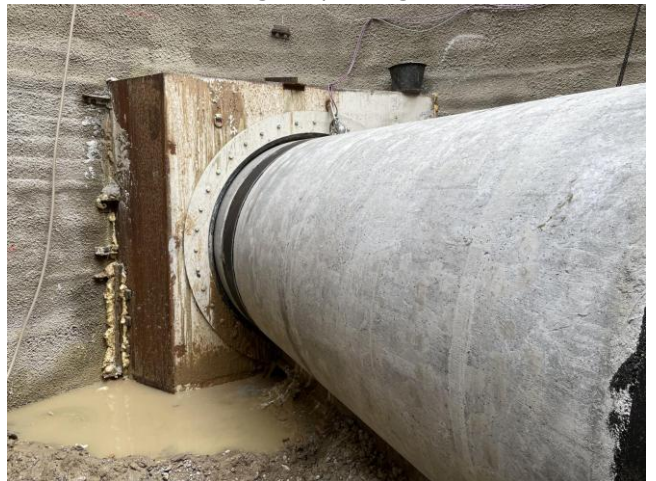
Rohrvortrieb aus Baugrube/Pressgrube S10
