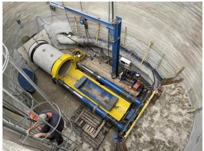
Rohrvortrieb aus Baugrube/Pressgrube S4
